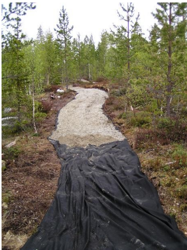
Veien under bygging
